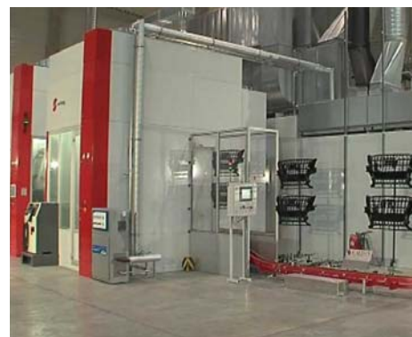
Zařízení Cryosnow s přívodem kapalného oxidu uhličitého (izolované potrubí)
