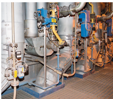
Systém REBOX® HLL instalovaný v peci
